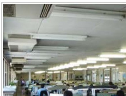
窓側の蛍光灯はすべて消灯
