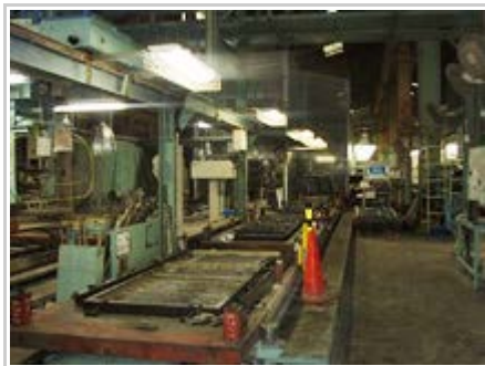
天井照明を消灯し、局所照明を実施
