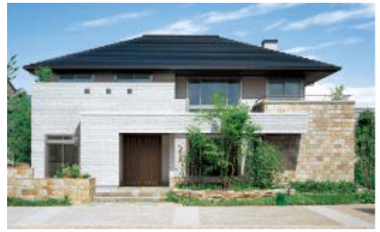
「省エネ・防災住宅」のモデルハウスの建築 (明石展示場: 当時)
