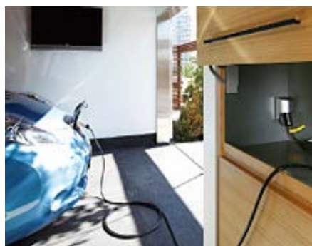
「観環居」でのEVとの共存
