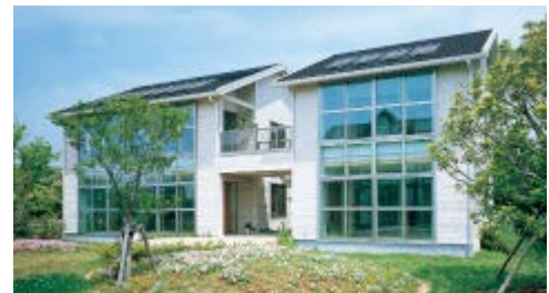
「ケミレスハウス®」実証実験棟
