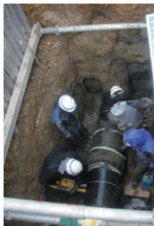
度重なる余震の中、懸命に進められた復旧工事
