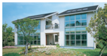
「ケミレスハウス®」 実証実験棟
