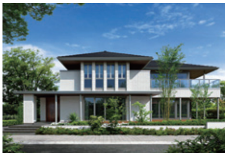
鉄骨2階建て住宅「イズ・ロイエ」
