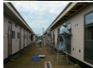
仮設住宅建設には全国の協力工事店が応援に駆け付けました
