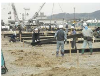
急ピッチで進む仮設住宅の建設
