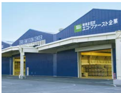
資源循環センター
