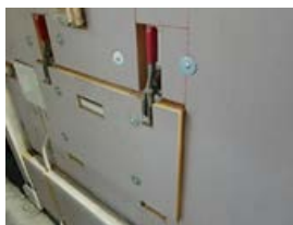
乾燥炉断熱の実施
