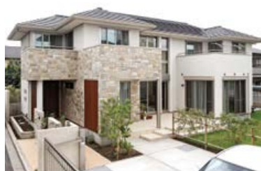
太陽光発電システムを5.2kw搭載
