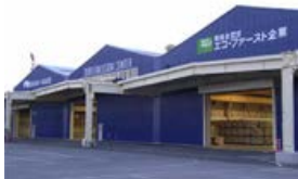
資源循環センター
