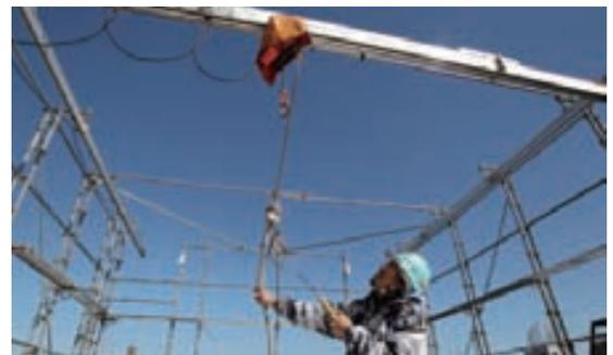
足場上部に現場仮設型天井クレーンを設置し、躯体・外装工事を施工する、オリジナルの「ガータークレーン」
