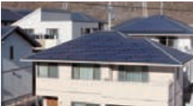
まちなみに配慮した瓦一体型太陽光発電システム
