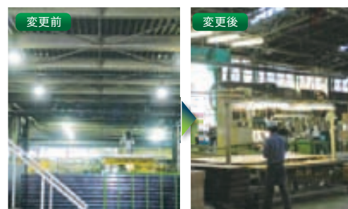
水銀灯による全体照明を、蛍光灯の手元照明に
