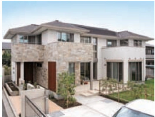
太陽光発電システムを5.2kW搭載
