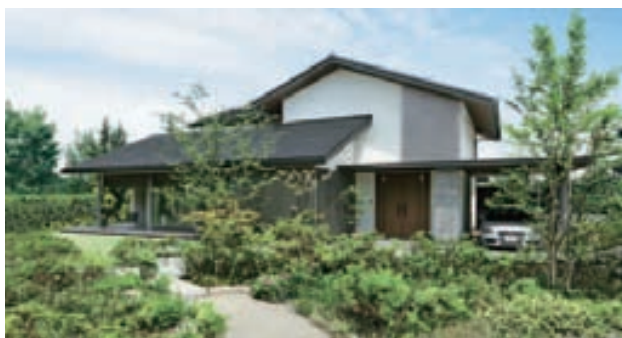
鉄骨2階建て住宅「ビー・サイエ」
