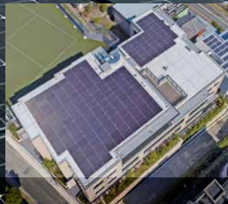
「GM覚王山菊坂町(愛知県)」の屋上に設置された太陽光パネル。景観や反射光にも配慮しつつ、発電効率の高いパネルをすき間なく設置することでZEH基準に必要な容量を確保しました。
