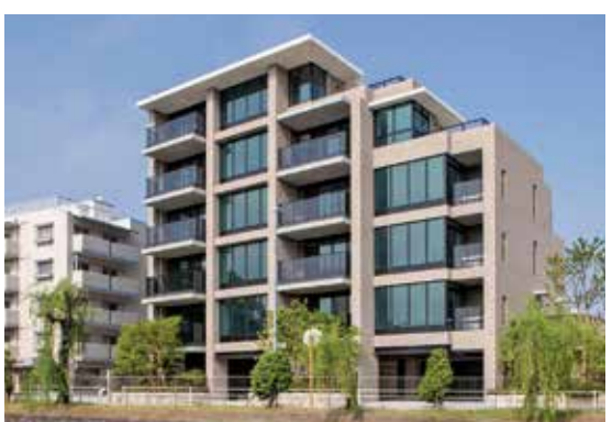
日本で初めて全戸に家庭用燃料電池「エネファーム」を設置した分譲マンション。さらに屋上には太陽光発電システムを搭載しており、「ダブル創エネ」仕様となっています。(GM 大濠Park /福岡県)
