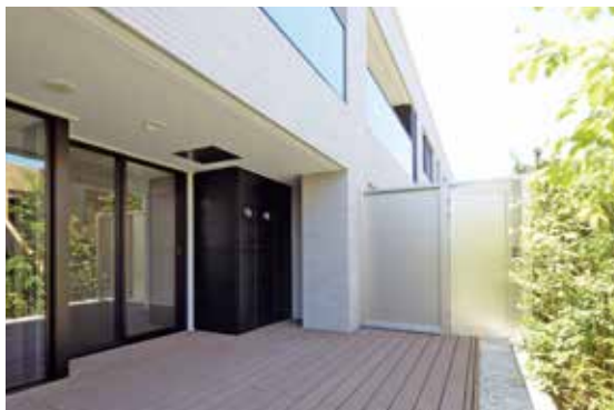
全戸にエネファームを導入した「GM上原コート」。植栽と空を眺めながらテラスでのんびりくつろぐとき、エネファームの存在感が気にならないよう、意匠を施しています。(GM上原コート/東京都)
