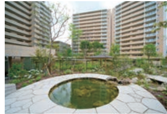
1300ℓの雨水を溜められる「雨水タンク」を中庭の地下に埋設。災害時の生活用水として利用するほか、普段は敷地内の小川や植栽への散水に利用しており、大切な水資源の保全にも貢献しています。(GM西九条BIO/大阪府)
