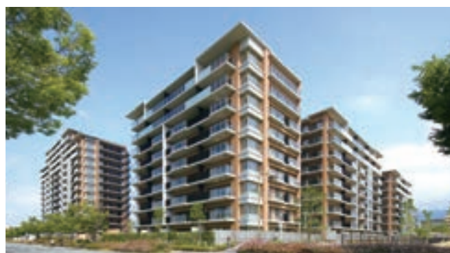
広大な敷地形を活かし、人が憩い、集う場所をつくる「ゆとり」をコンセプトに設計。各棟は地震に強い耐震構造で建てられています。(六甲アイランドCITY W7Residence/兵庫県)
