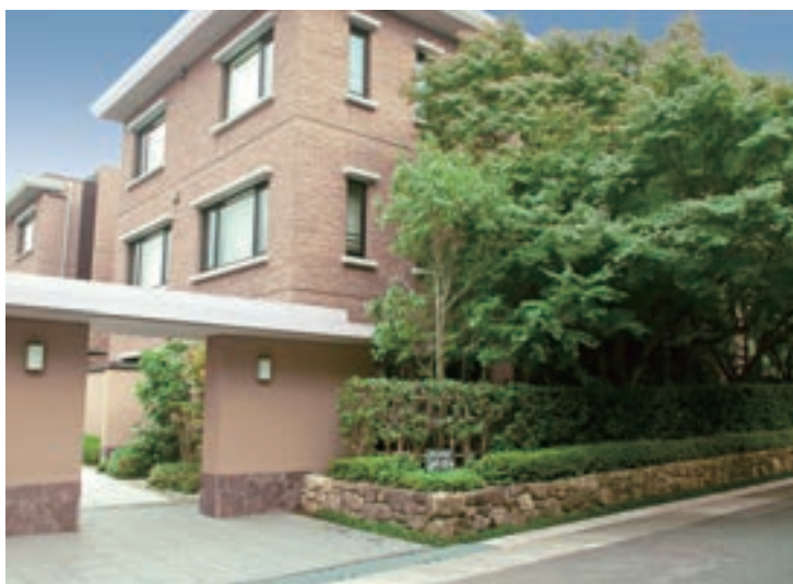
GM南山ヴァンクール（愛知県）／既存樹は高さがあり枝張りも大きいので、美しい目隠しにもなります。樹木の下には生け垣と下草、石積みを重ね、邸宅街にふさわしい厚みのあるデザインに仕上がっています。
