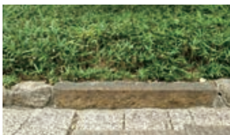
GM白壁櫻明荘(愛知県) / 深い味わいを持つ石も残して、アプローチの土留めとして再利用しました。古材も可能な限り残して、活用しています。
