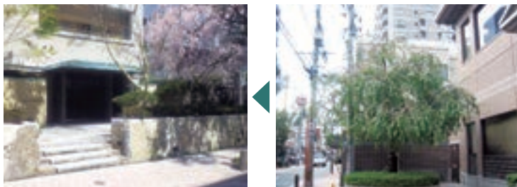
GM大濠公園2011(福岡県) / ご近所の方々に愛されていた枝垂れ桜を保全。竣工後、無事に花も咲き、皆さんから非常に喜ばれた一例です。
