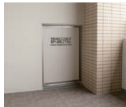
バルコニーの避難ハッチ(写真右)や隔板(写真上)は、災害時の大切な避難経路になります。日頃から物を置いてふさがないように注意しましょう。
