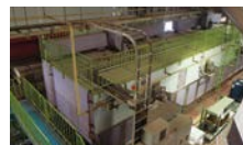
乾燥炉扉の外張り断熱
