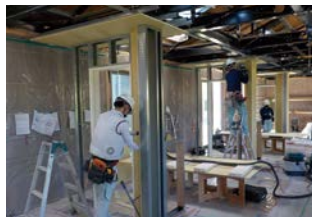
内装施工コース 修了試験風景
