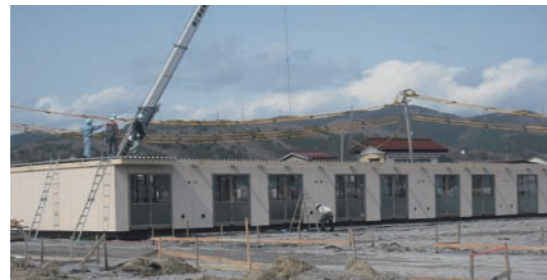
急ピッチで進む仮設住宅の建設
