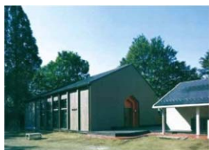
70mに及ぶ屋根を利用した太陽光発電
