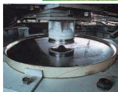
建物を支え、地震の揺れを受け流す免震装置
