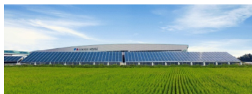
積水ハウス東北工場
