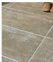
玄関土間にも 対策を 土間タイル
