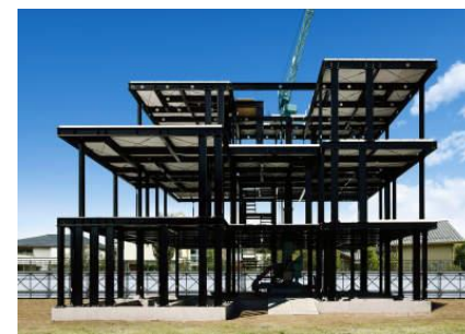
3・4階建て構法 フレキシブルβシステム
